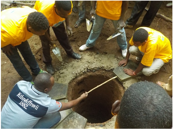
የፌዴራል ብሎክ የተከላ ስልጠና በቴክኒክ እና ሙያ ተቋም መምህራን በአቶ ታረቀኝ (ፍትላፊት በስተቀኝ) (ፎቶ ከዋስ ሮፕስ)
