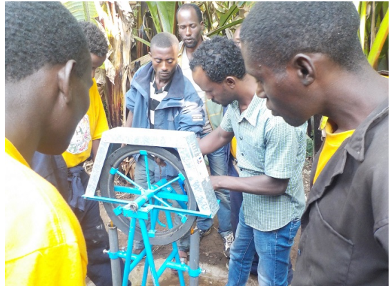
የጥራት ቁጥጥር ከተከላ በኋላ በአቶ አለነ የጃይካ ዋስ ሮፕስ የቴክኒክ ረዳት (ፎቶ በዋስ ሮፕስ)
