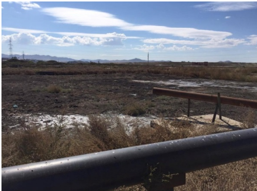
汚泥をパイプラインを通じて移送
