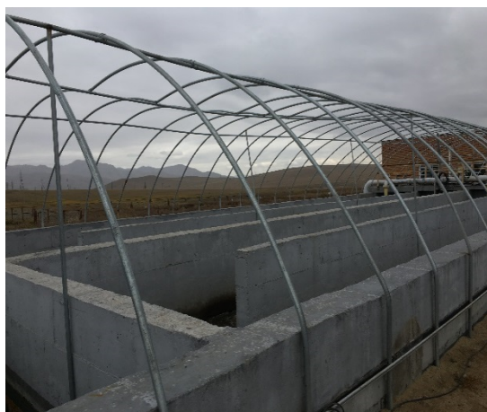
バガヌール下水処理場の全景
