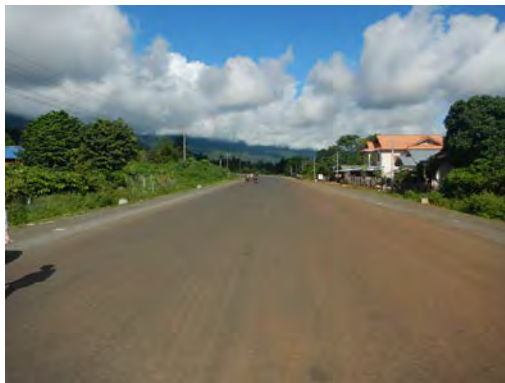
NR1I (セコン県) 村落部車道 16.6m
