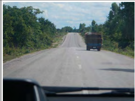
NR13S（サバナケット県） 車道 9.0m、DBST 舗装
