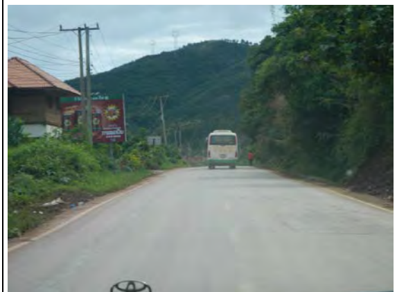
NR13N（ルアンナムタ県、北側） AC舗装、車道 3.5m×2、路肩 0.5m 両側
