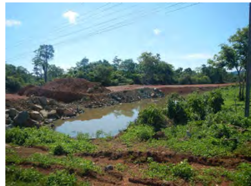
NR18A (NR13 交差点) 盛土施工
