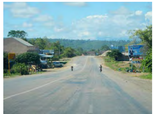
NR1I (セコン県) 村落部 4車線
