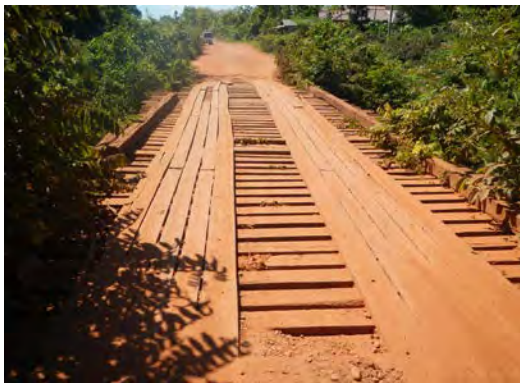
NR18A (アッタプー付近) 木橋
