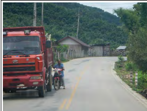
NR13N（ウドムサイ県、サイの北側） AC舗装、車道 3.0m×2、路肩 0.2m コンクリート両側
