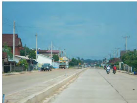
NR10（北端付近） コンクリート舗装、4車線
