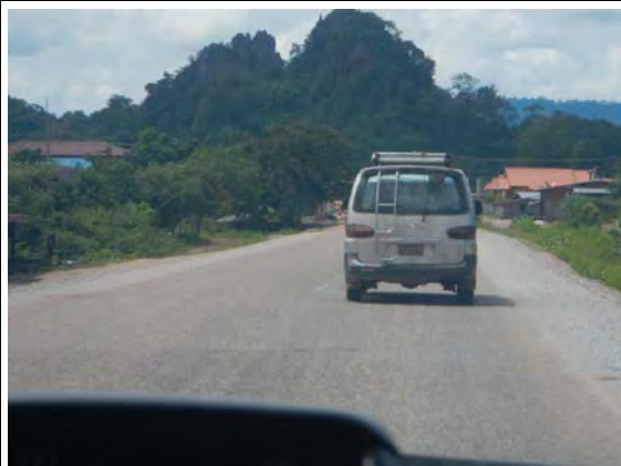
NR1E（カムアン県、NR12 付近） DBST、W=7.0m+砕石路肩 1.0m
