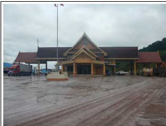
ラオス側国境施設
