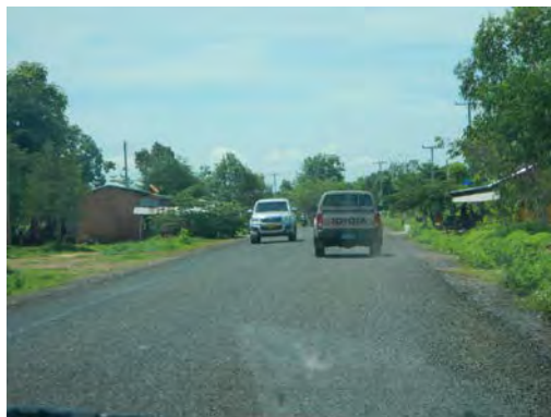
NR18B (アッタプー県) 車道 7.0m、0~37km
