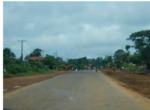
NR16A（パクセ～パクソン間） 車道 7.0m、拡幅工事中
