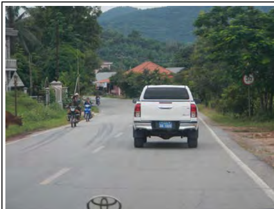
NR3（ルアンナムタ県、ルアンナムタ付近南側） 車道 3.5m×2、路肩 0.5m 両側
