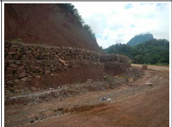
ラオス側国境施設区域内道路の布団かごによるのり面防護
