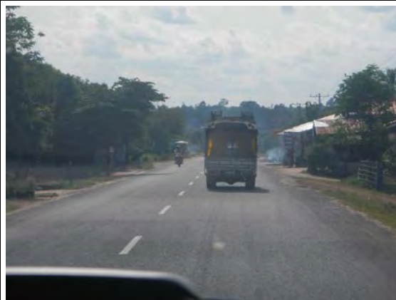
NR9B（サバナケット県） 車道 9.0m、DBST 舗装
