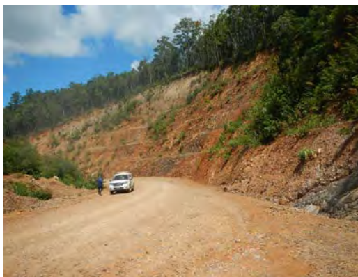
NR16B（セコン県） 碎石舗装、35km～113km
