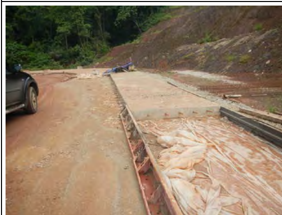
ラオス側は国境施設区域内道路のコンクリート舗装を施工中
