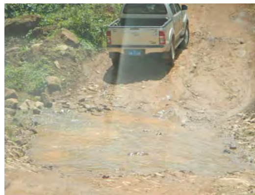
NR16B（セコン県） 横断水路構造物必要箇所（数か所）
