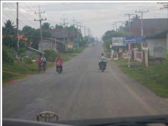
NR13N（ルアンパパン県、北部 NR1C 以南） DBST 舗装、W=7~8m
