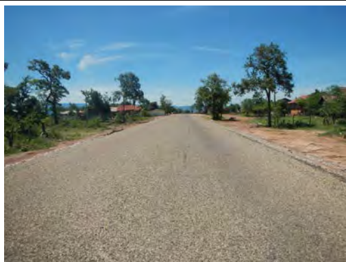
NR1J (アッタプー県) 車道 9.0m
