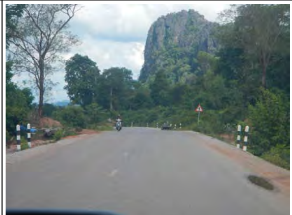
NR1F（カムアン県、NR12 付近） DBST、W=7.0m+砕石路肩 1.0m
