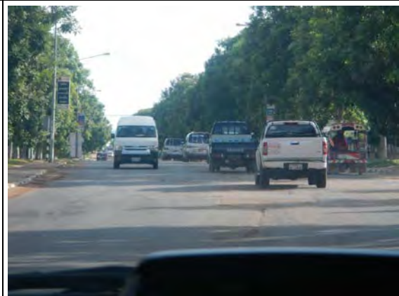
NR9（サバナケット県、サバナケット付近） 車道 9.0m、DBST 舗装
