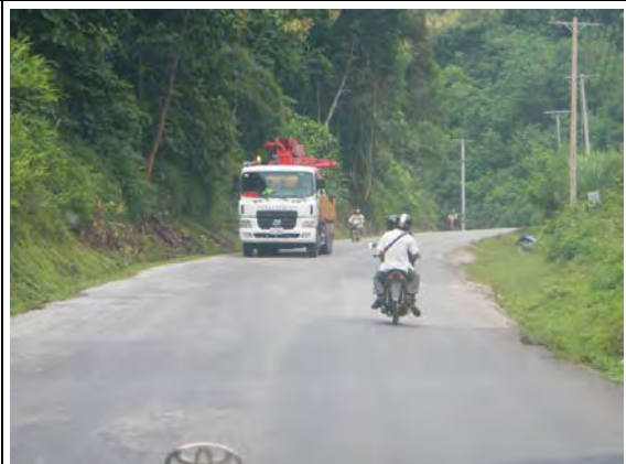
NR13N（ルアンパパン県、ルアンパパン南部） DBST 舗装、W=7~8m
