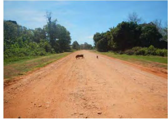
NR18A (アッタプー付近) 土道
