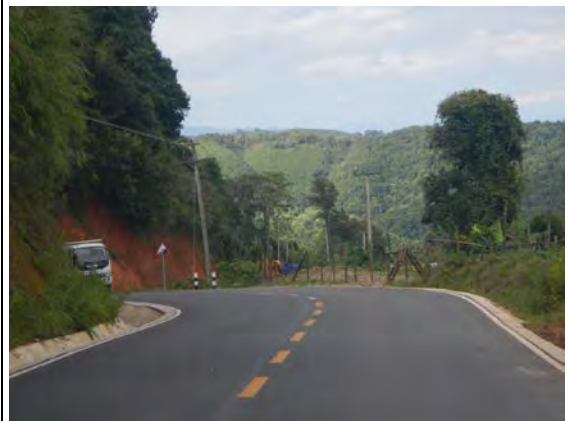
NR13N（ルアンパパン県、北部 NR1C 以北） AC 舗装、車道 3.5m×2、路肩 0.2m コンクリート両側
