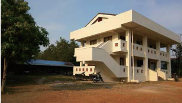
環境プロジェクト無償「森林保全計画」にて 供与された建物（セイマ保護林管理事務所）
