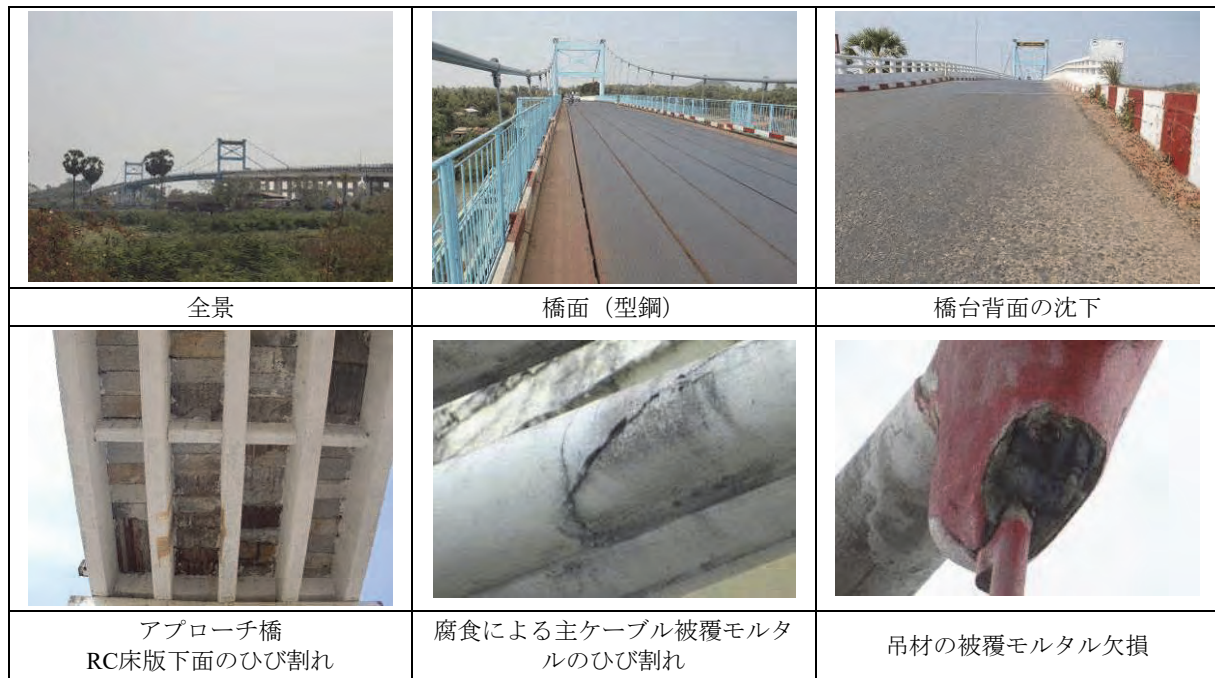
図 2.5.15 エインドゥーミャワディ区間の主な橋梁現況（ジャイン・コーカレー橋）
