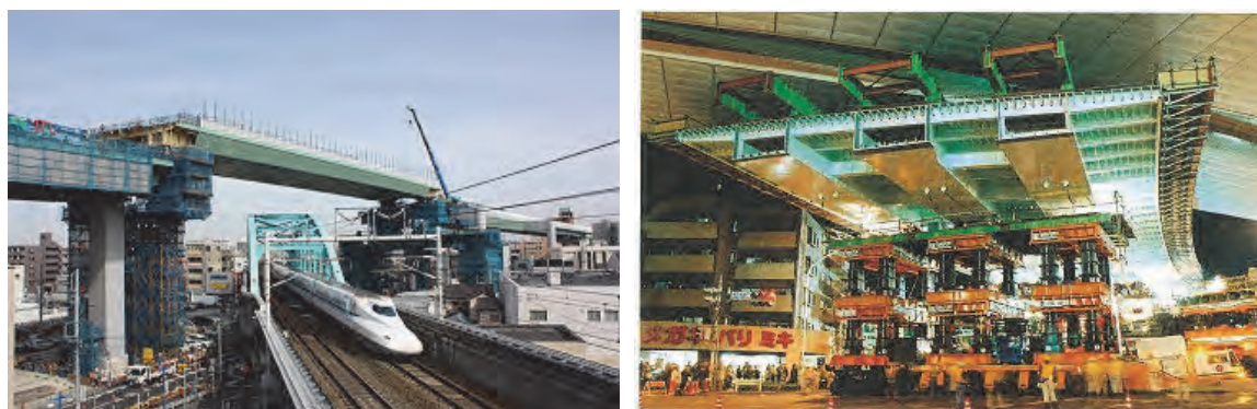
図 7.2.9 送出し工法（左）及び多軸台車（右）による架設の事例
