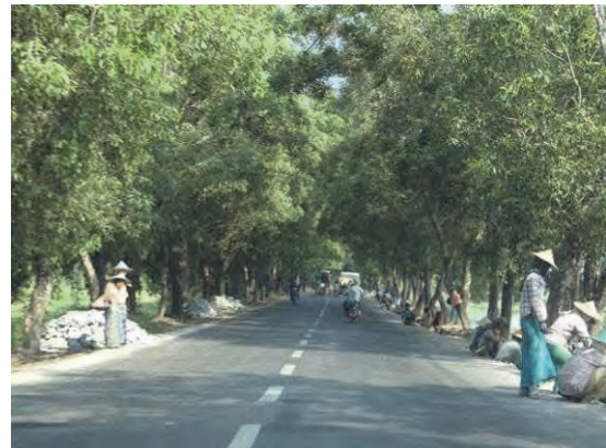
写真19 ザタピエン～パアンの路面状況
