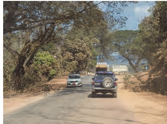
写真8 エインドゥ〜コーカレーの路面状況
