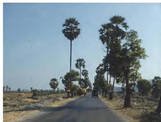
写真15 AT橋～GZ橋の路面状況
