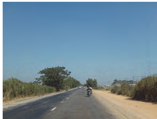
写真2 バゴー～パヤジの路面状況
