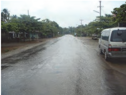
写真7 タトン〜エインドゥの路面状況
