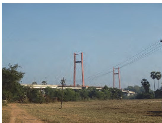
写真14 アトラン（AT）橋
