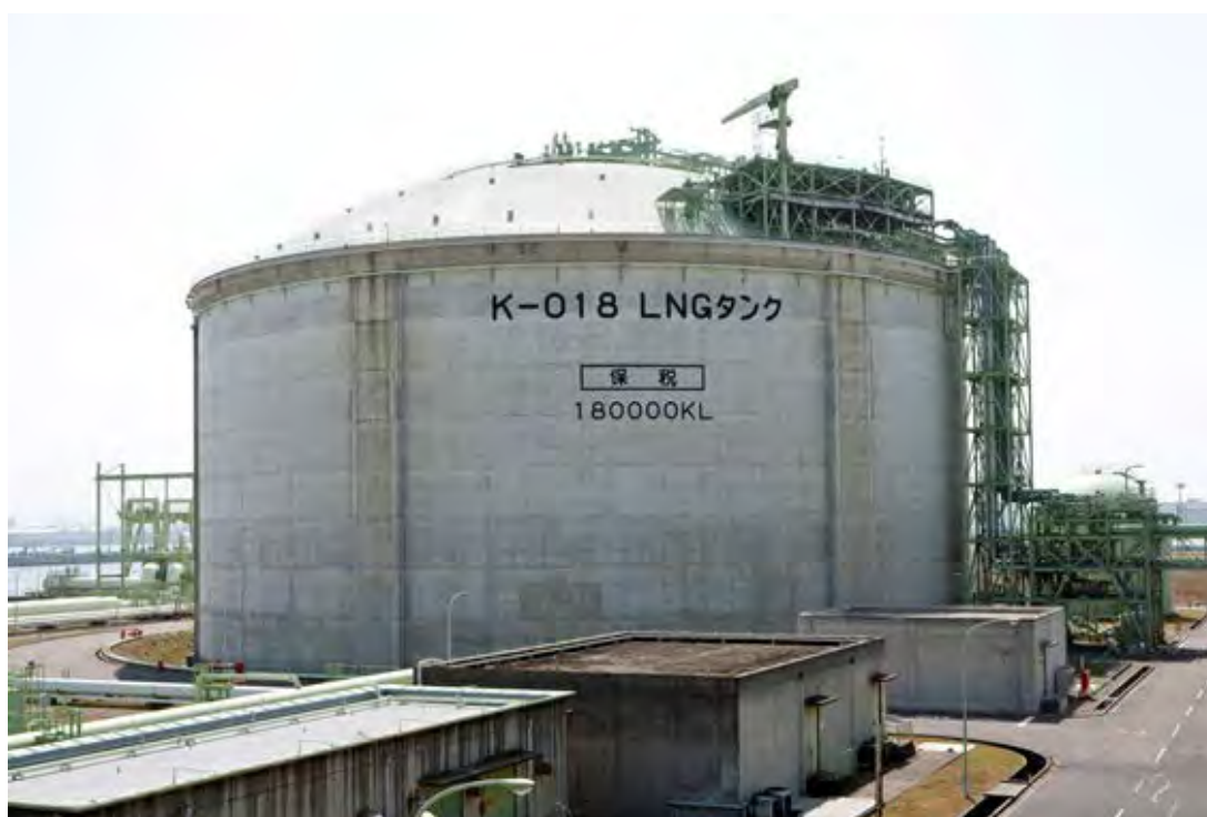
図 8-23 地上式ドームルーフ型 PC LNG 貯槽タンク外観
