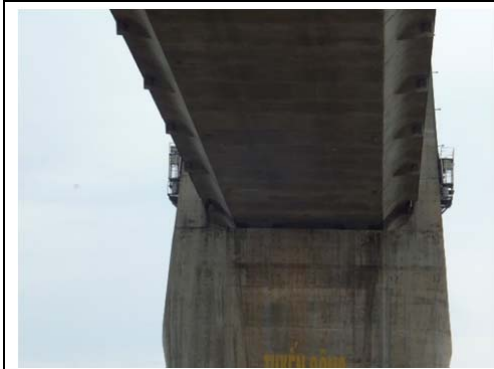
Dầm hộp bê tông cốt thép. Các dầm hộp được cấu tạo từ các phân đoạn.
