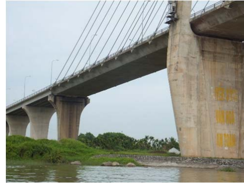
Hộp dầm nhịp bên đã được sơn. Không rõ lý do.
