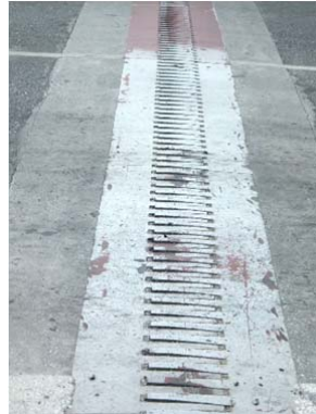
Phần khe co giãn trên cầu dẫn phía nam đã có lại tối đa và đã va chạm một chút.
