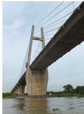
Dầm hộp bê tông và tháp phía bắc.
