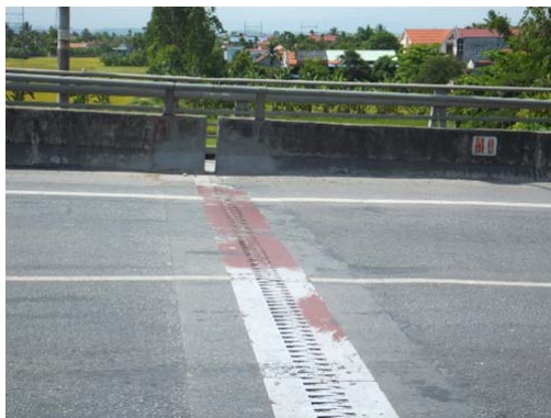
Các khe co giãn đã được thay thế bằng những cái mới.
