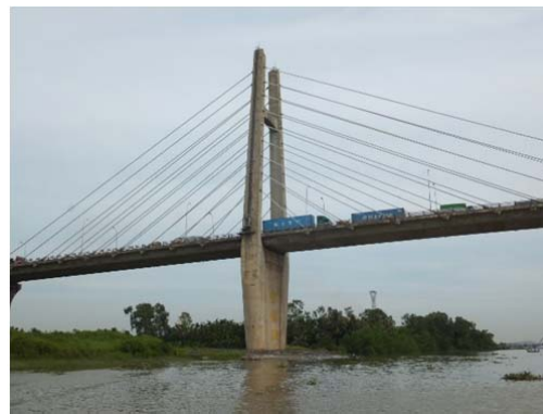
Xe tải lớn đi trên mặt cầu.
