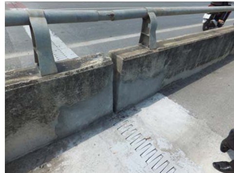
Tất cả các khe co giãn trên Kiên Cầu đã được thay thế. Không rõ lý do.
