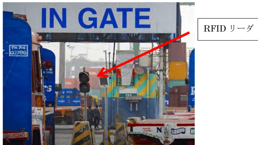
写真 3-9 PSA ゲート付近の RFID 読取機
