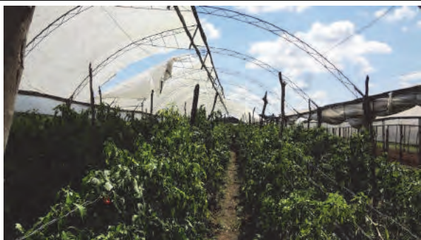
雹による被害で2年前から破損したままの温室
