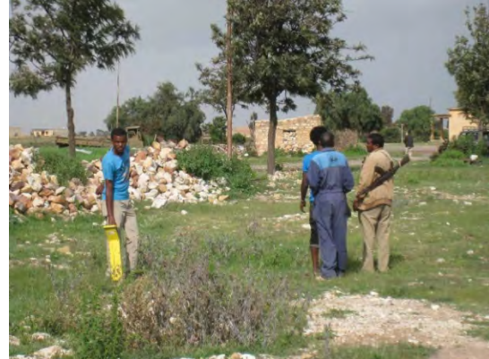
管路ルート簡易測量実施状況
