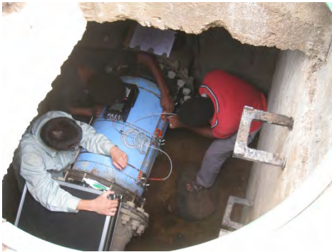
流量測定訓練状況
