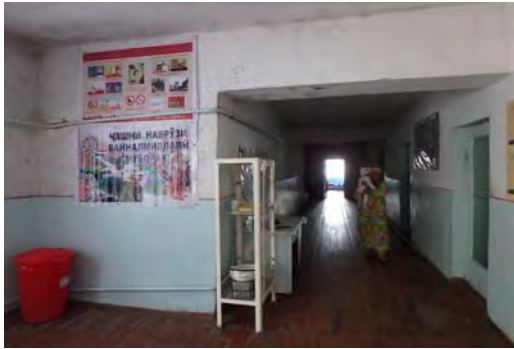
廊下: エントランスと同様に非常に暗く、開口部がないため風通しが悪い。
