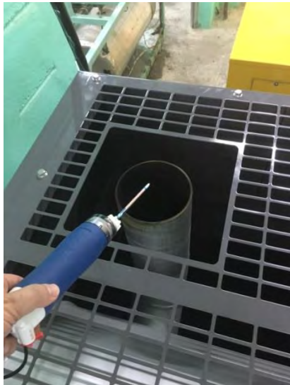
発電機（DCA-300ESK）排ガス検査 （2016 年 1 月）
