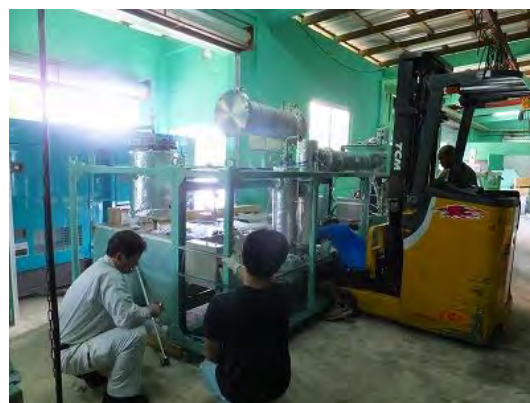
写真2：実証サイトにおける油化装置の組立、据付設置（2016年1月）
