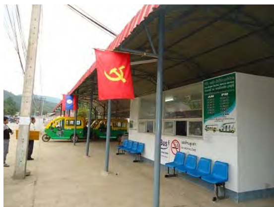
車庫、待合所、切符売り場を 備えた EV ステーション (2015 年 12 月)
