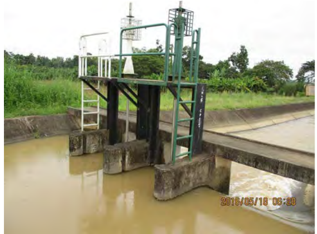
プロジェクトサイト二次水路施設
