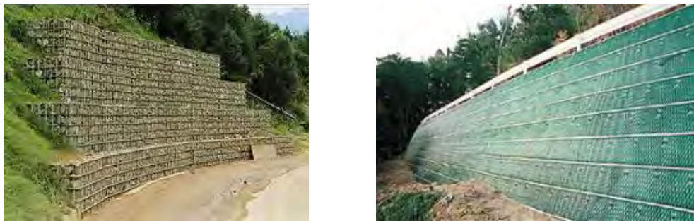
図 6.4-2 布団籠及び補強土壁を用いた盛土構築例
