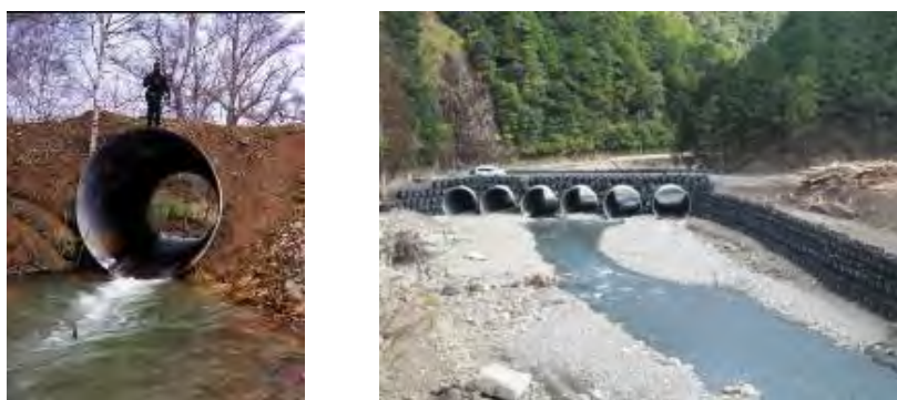
図 6.4-1 コルゲートパイプを利用した仮設道路
