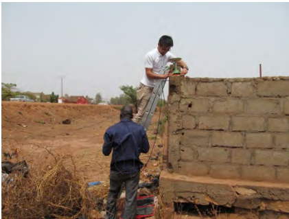
L'installation de l'antenne de GNSS
