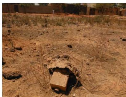
写真 3-1 既存基準点の現状（左：正常な基準点（D0050）、右：破損点（T58））
