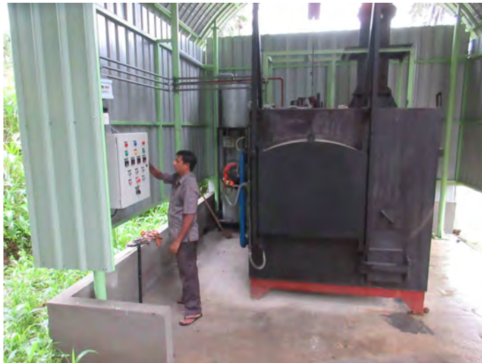
写真 16 Homagama Base Hospital に設置されたスリランカ製の医療焼却炉
