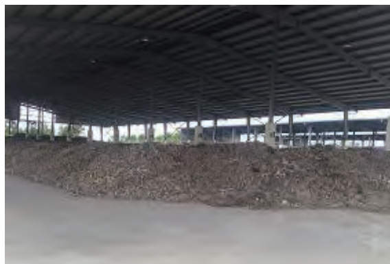
Trang Cat 最終処分場内の堆肥化施設
