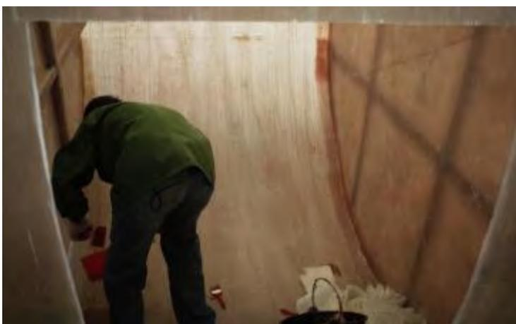
タンク内部の仕切板の加工作業
