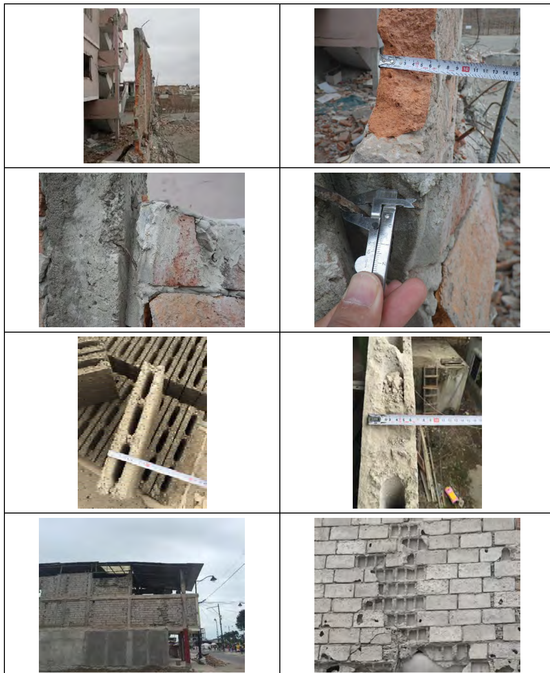
写真 3-38 組積壁の施工状況
