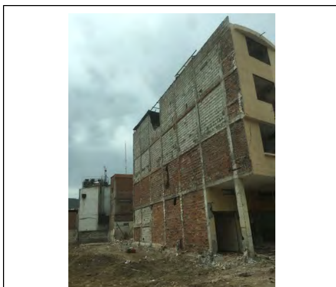
写真 3-31 RC柱-スラブ+インフィル壁構造
