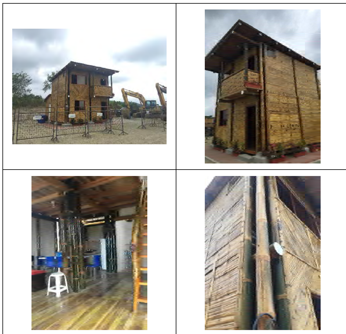
写真 2-3 ケース1の敷地移転先で建設されていた竹によるデモモデル住宅
