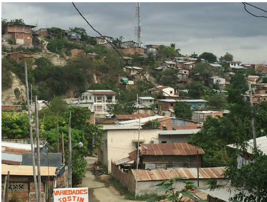
写真 3-35 エクアドル被災地域のノンエンジニアド建築群
