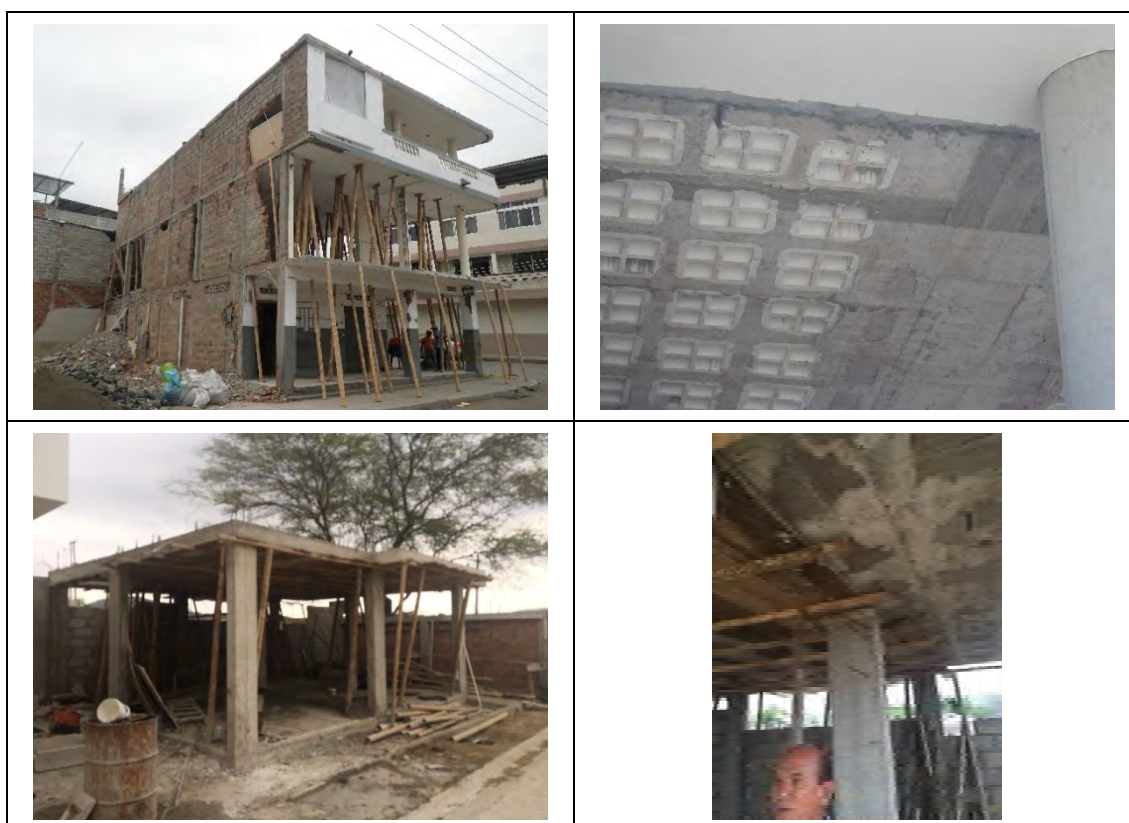
写真 3-39 床スラブ施工事例
