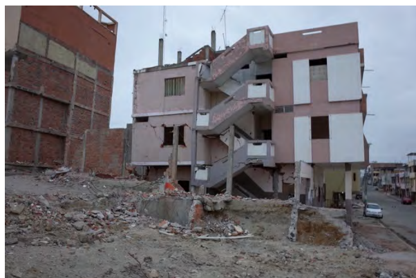
写真 3-28 撤去された建物の基礎部分と残存建物
