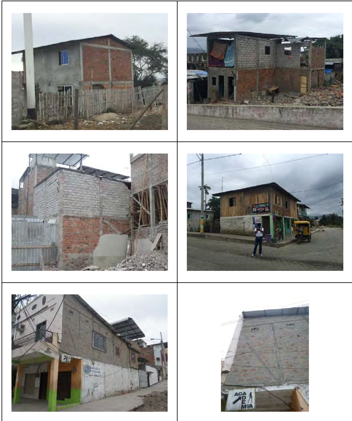
写真 3-36 一般的な建設工法
