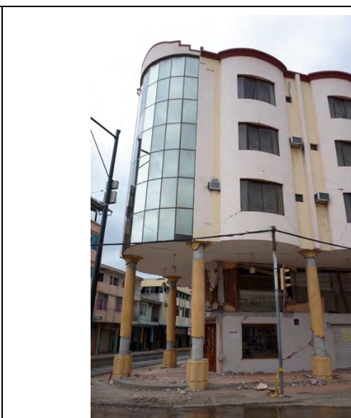
写真 3-30 3階以上がせり出した典型的建築
