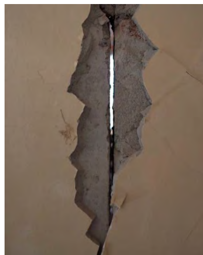
写真 3-17 アンカーのないインフィル壁
