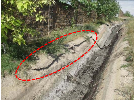
Նկար 4-4-4.1 Ճեղք ջրանցքի կողային պատի վրա (Արգնի ճյուղ ջրանցք No.26 կետում)
