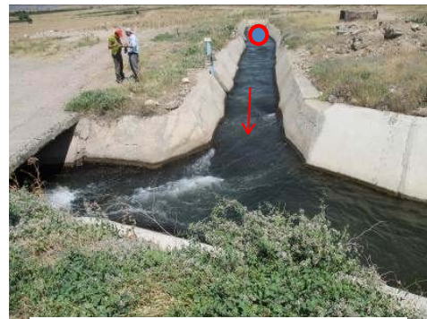
Նկար 4-4-4.4 Ելքային խողովակ Արգնի-Շամիրամ ջրանցքից (ø800մմ) (Արգնի ճյուղ ջրանցք No.25 կետում)
