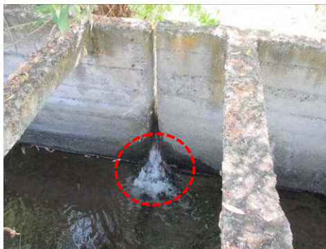
Նկար 4-4-4.3 Արտահոսք կողային պատերի կարանի անջատումից (No.33 կետում)
