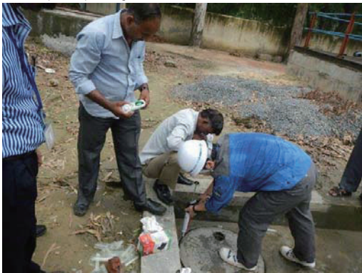
耐水性試験用モデルチャンバーのマンホールに専門家のガイダンスの下、防水加工を行う DJB 職員。
