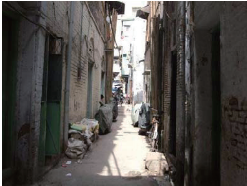
Central I 事務所の周辺地域。デリー市内でも最も古い地区。狭い路地に配管、電線が複雑に張り巡らされており、プロジェクトで行った既存管の調査も時間を要した。
