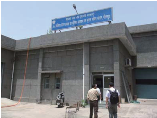
SCADA オペレーション予定サイトのビタンブラ配水池。
