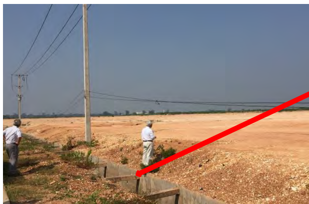
排水路のコンクリート製の支柱は水分を含んだ土の膨張により押され、既に湾曲してしまっている。
