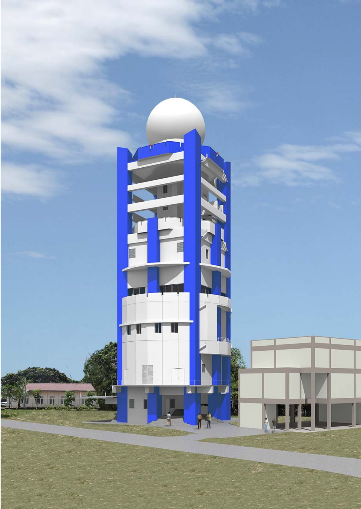
ポトゥビル気象レーダー塔施設
