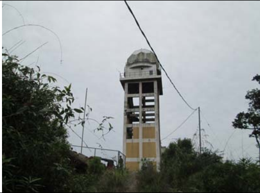
既設ゴンガラ気象レーダー塔施設全景
