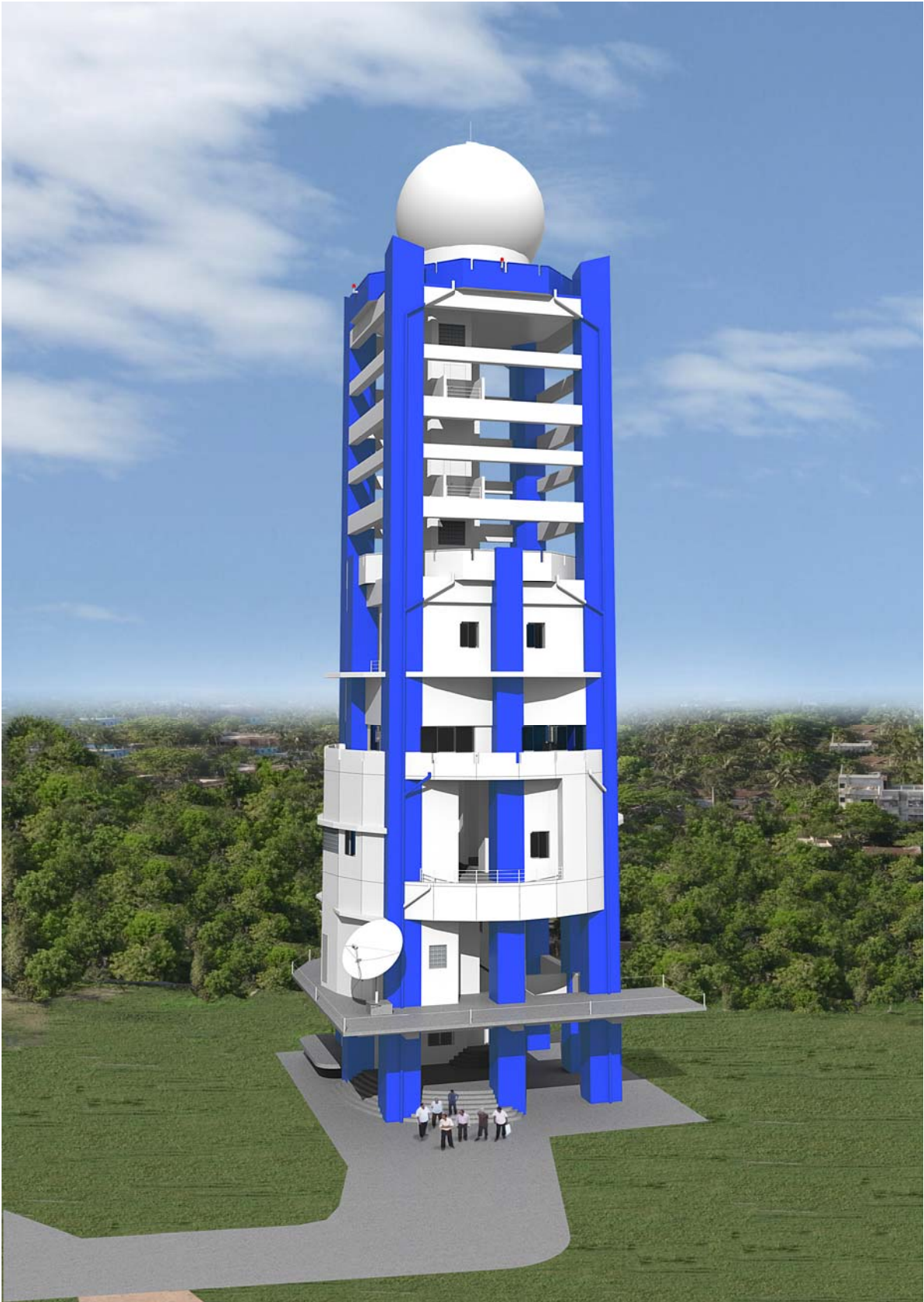
プッタラム気象レーダー塔施設
