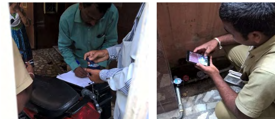
図 3-15 給水管用 L-sign 設置準備の様子
