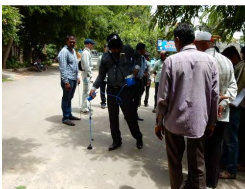
漏水探知器による音聴調査実習
