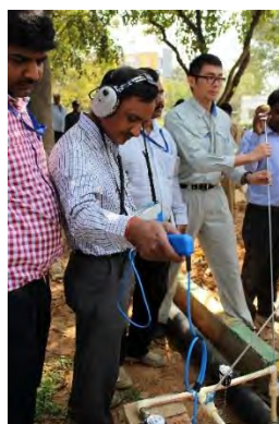
図 3-29 音聴式漏水検査機器の利用
