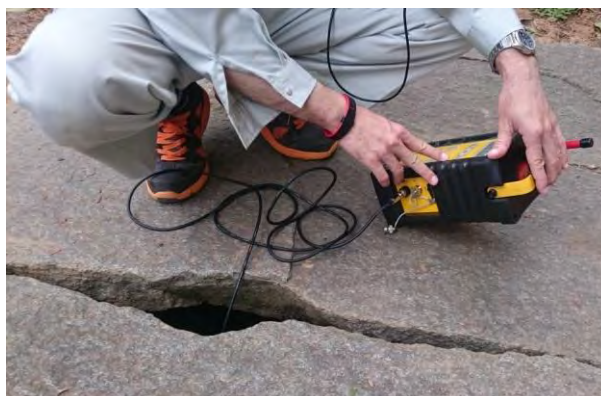
図 3-25 相関式漏水探知器の实地研修
