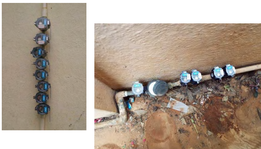
図 3-9 現地での感度再検証の様子
