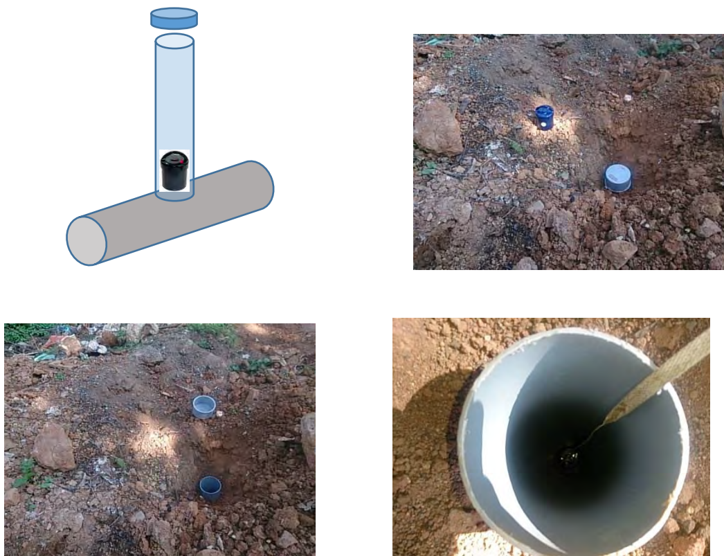
図 3-18 配水管チャンバー (左上：模式図、右上・左下・右下：設置写真)
