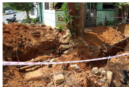
図 3-33 現地漏水発見場所
