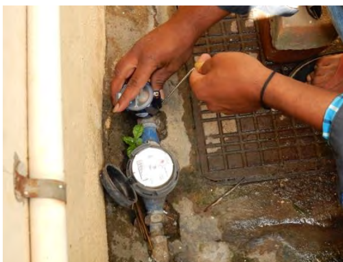
パイロットテスト地区における L-sign 設置
