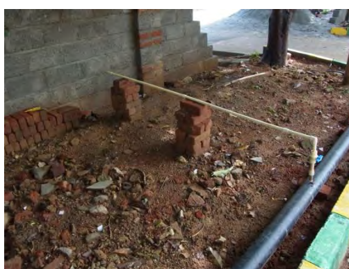
漏水調査技術トレーニングヤードの設営 仮設配管設置状況
