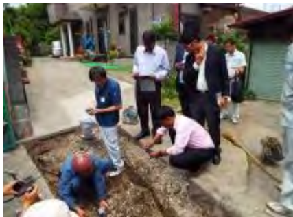
漏水管路の掘削視察
