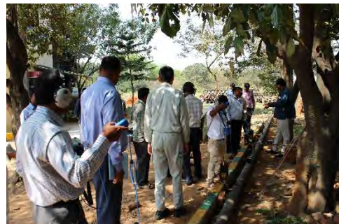
図 3-27 テストヤードの試験管路
