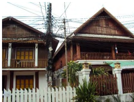
架空ケーブル
