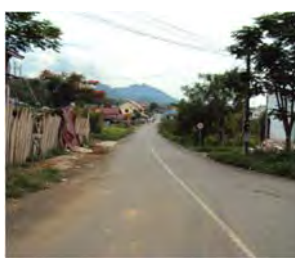
歩道・排水路無い道路
