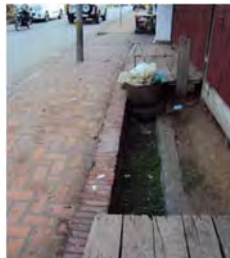
閉塞排水側溝
