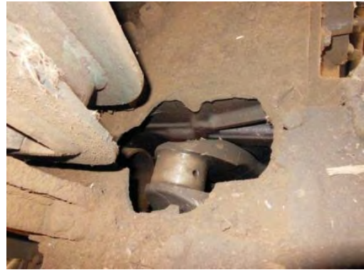
ピストンの接続棒が外れて突き破った様子
