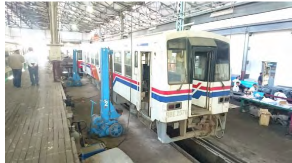
RBE 工場（リフティングジャッキ）
