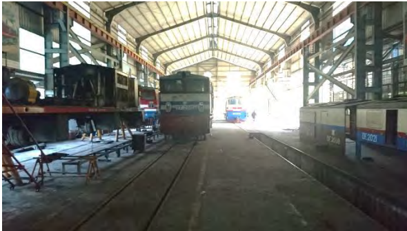
インセイン工場 (エンジン艀装場の増築部)
