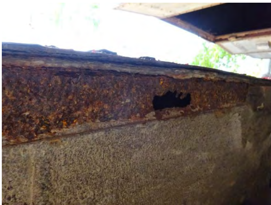
図 4-3-1 台枠が錆びて穴があいている状態
