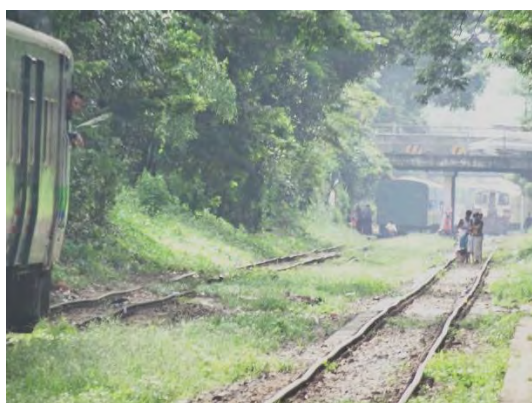
軌道の状態（ヤンゴン環状鉄道）
