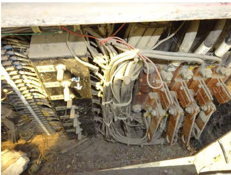
図 4-3-2 雨ざらしでの状態で腐食が進行している電気部品
