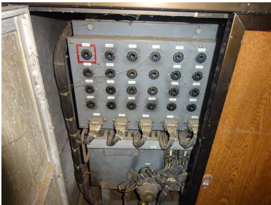
図 4-3-3 継電器がすべて外された状態
