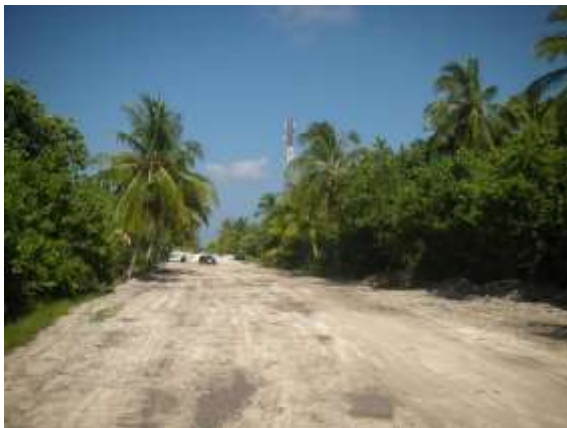
ガン：鉄塔建設予定地の周辺
