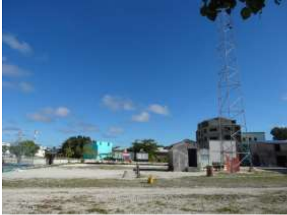
ナイファル：鉄塔建設予定地
