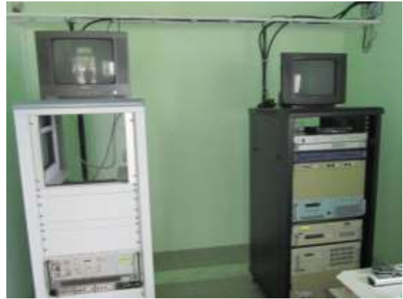
ビルンギリ：アナログ放送用機材及び FM ラジオ用機材
