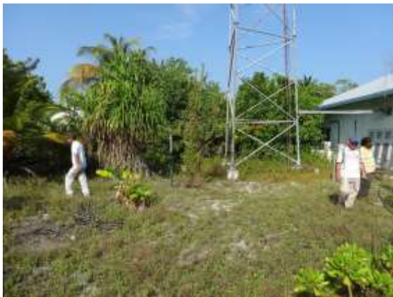
クルドゥフシ：既設局舎・鉄塔
