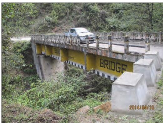
テレガンチュ橋 : RC-T 桁橋
