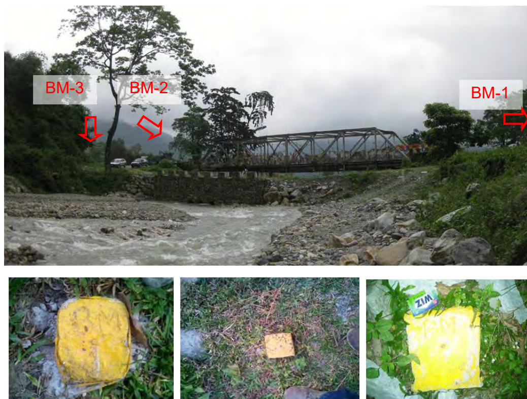
(BM-1 は、写真外にあるヒンズー寺院入口の道路端に、BM-2 は橋梁下流側左岸平地に設置)
