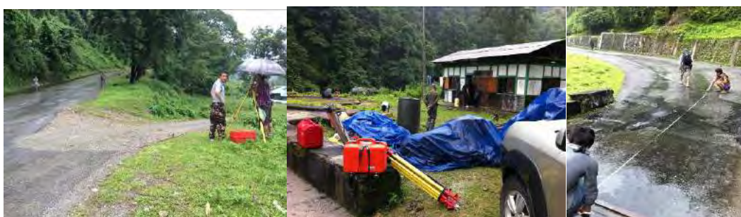
図 2.2.35 トータルステーション測量の現場作業状況
