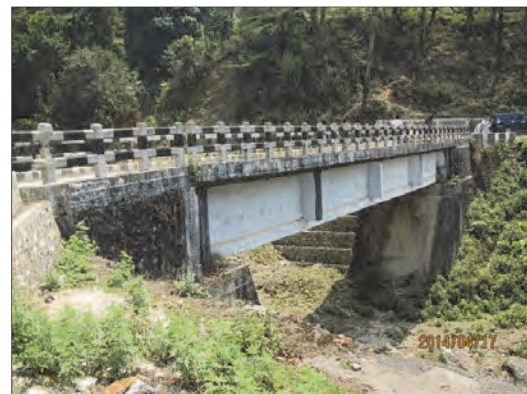
ペテニ橋 : RC-T 桁橋 橋長約 25m、幅員 4.2m 1987 年建設
