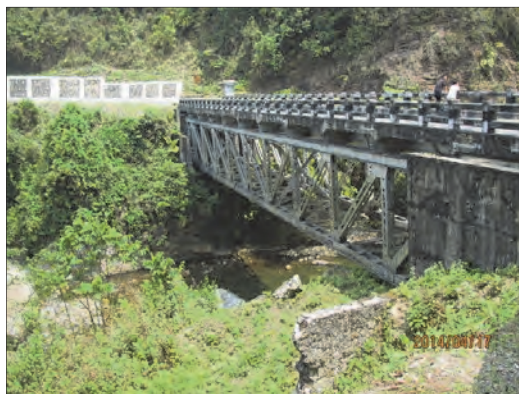
サムカラ橋 : 鋼トラス橋 橋長約 61m、幅員 4.3m 2001 年建設
