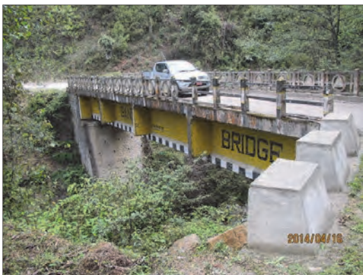
テレガンチュ橋 : RC-T 桁橋 橋長約 25m、幅員 4.5m 1981 年建設
