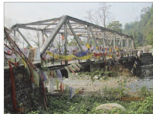
パッサン橋 : 鋼トラス橋 橋長約 40m、幅員 7.5m 1970 年建設
