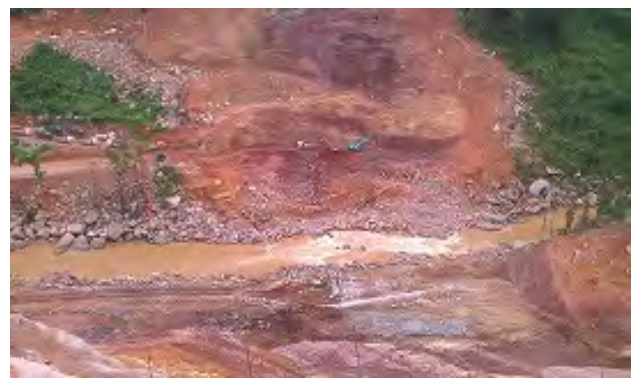
メインダム底部の掘削の様子（高低差 150m）
