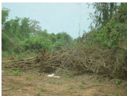
ダム建設現場の道路脇
