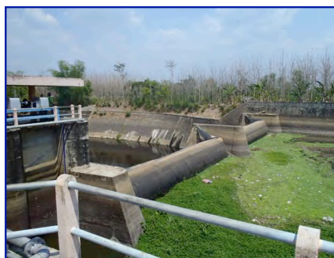
写真-11 ジャチの全景 (JICA案件化調査団撮影)
