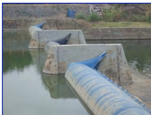
写真-10 ランバタン全景 (JICA案件化調査団撮影)
