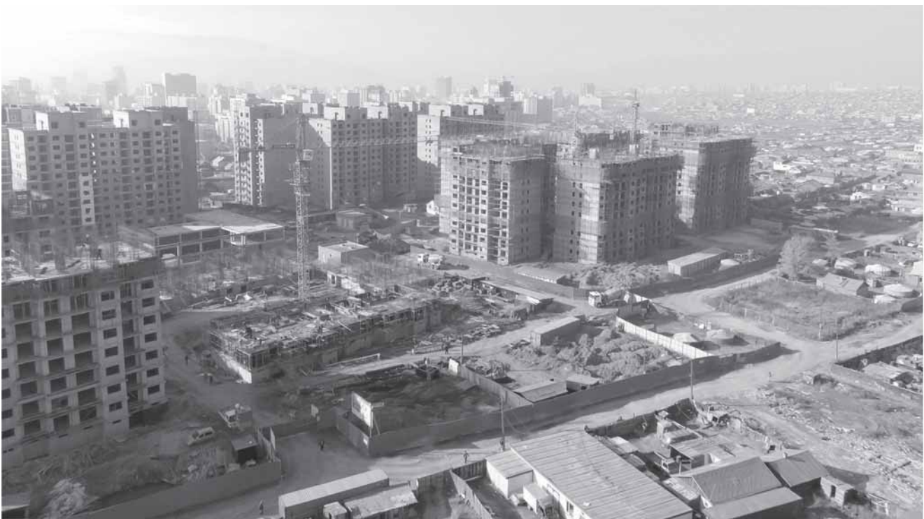
En Ulán Bator, capital de Mongolia, la JICA apoya el establecimiento de una ley de reordenamiento urbano y su implementación, para mejorar la deplorable condición del medio ambiente habitacional en las áreas con ger .
