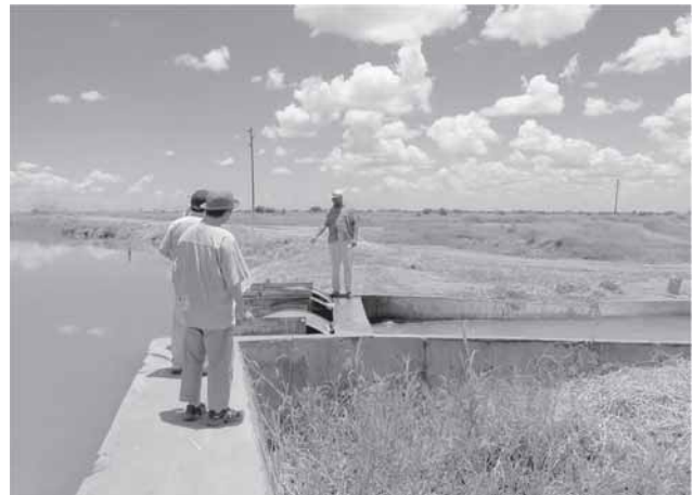
La JICA apoyó la remodelación del sistema de riego en Shokue, Mozambique, destruido por una inundación.
