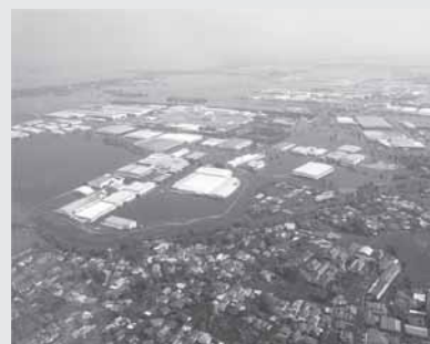
Un parque industrial cubierto de agua después del desbordamiento del Río Chao Phraya.
