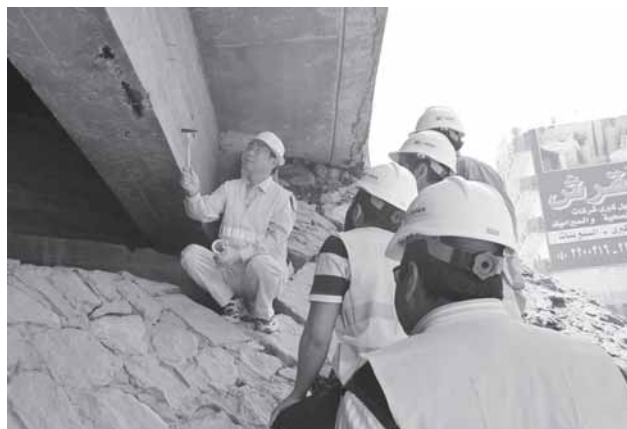
Ingenieros egipcios aprenden los métodos de inspección de puentes. (Proyecto para el Fortalecimiento de la Capacidad de Manejo de Puentes.)
