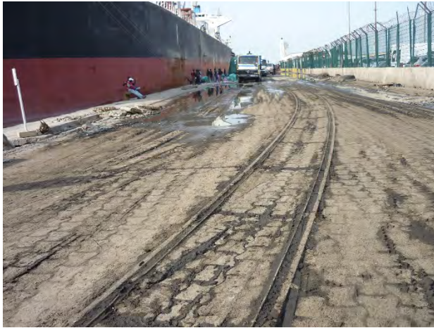
Photo 9 : Rail de chemin de fer existant du môle 3
