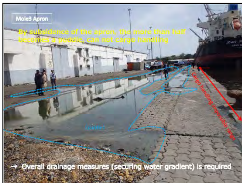
(2) Vétusté, quai endommagé, flaques d'eau entraînant des odeurs nauséabondes à longueur de temps
