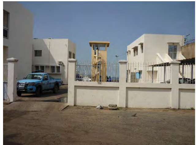
Photo 6 : Poste de pilotage à l'extrémité du môle 6
