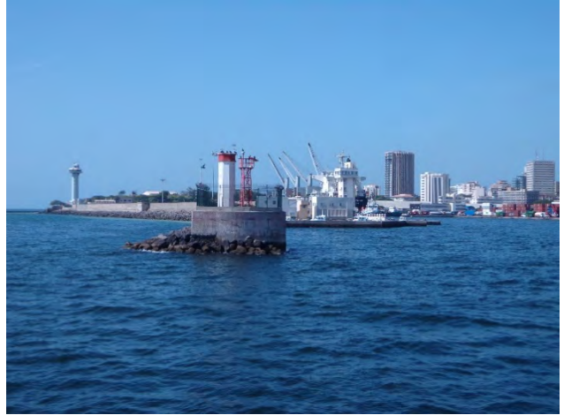
Photo 4 : Extrémité du brise-lames Sud à l'entrée du Port de Dakar (tour de contrôle à l'extrême gauche)
