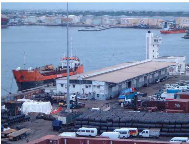
Photo 7 : Vue d'ensemble de l'entrepôt (photo prise depuis la tour de contrôle)
