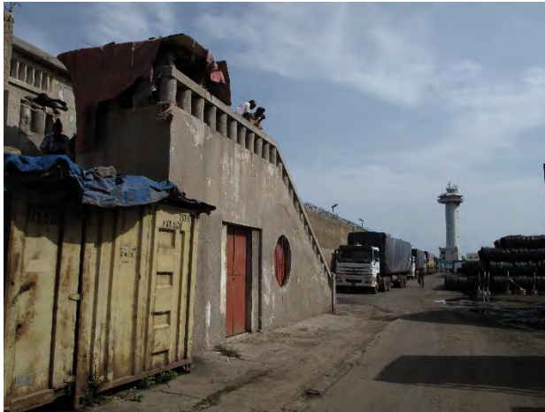
Photo 15 : Toilettes du môle 3 (à l'étage)
