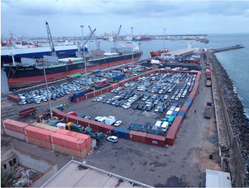
Photo 1 : Vue d'ensemble du môle 3 (septembre 2015)
