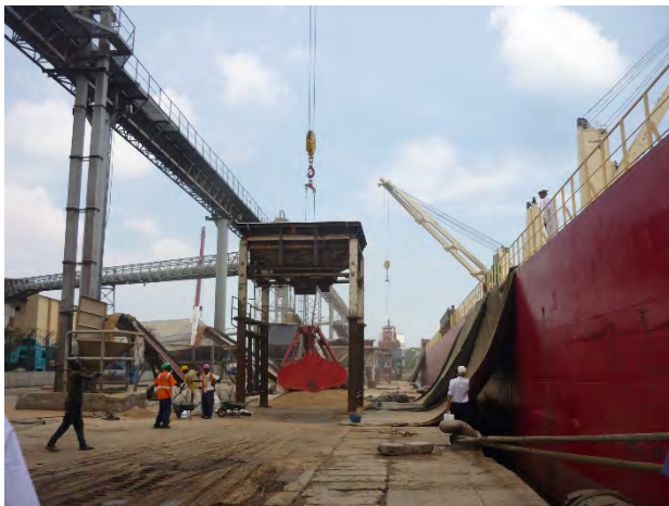
Photo 17 : Travaux d'embarquement de céréales au moyen d'un silo et d'un convoyeur surélevé au môle 4
