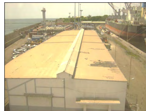
(6) Entrepôts (porte inutilisable du côté du quai et toiture endommagée)
