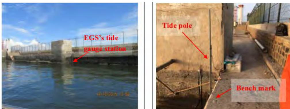
写真 6-3-1 潮位計の設置位置写真
