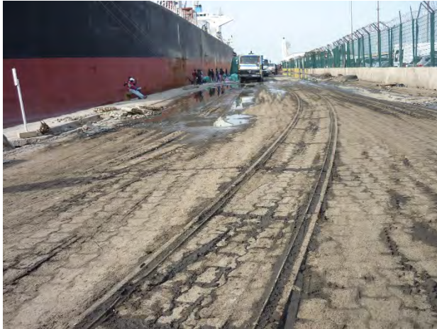
写真-9 第三埠頭既存の鉄道レール
