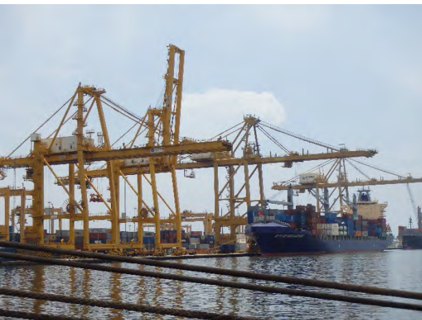
写真-19 第四埠頭から第六埠頭を望む (コンテナターミナル)
