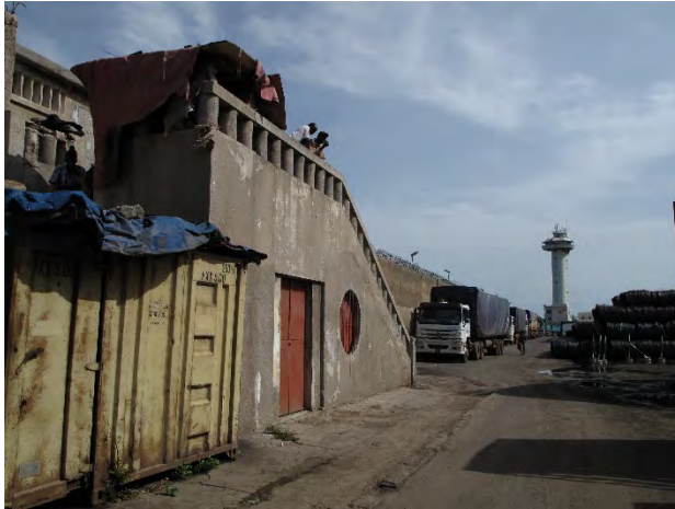
写真-15 第三埠頭のトイレ(階上)
