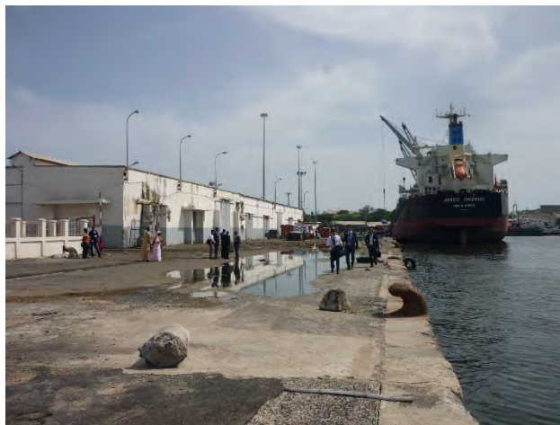
写真-5 第三埠頭を沖側から望む (左側が既存倉庫)
