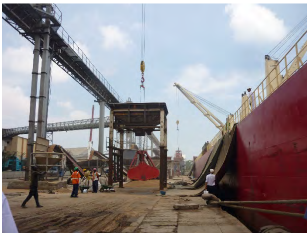
写真-17 第四埠頭での漏斗と高架バルコ ンを用いた穀物の荷揚げ作業
