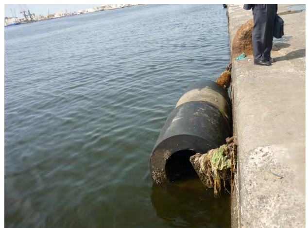
写真-14 第三埠頭岸壁の防舷材
