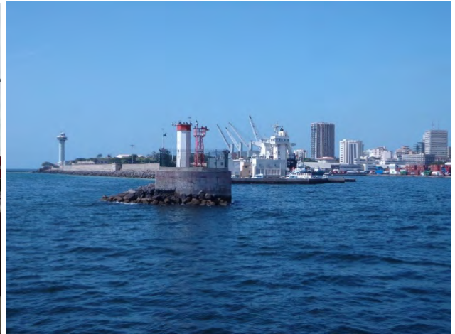
写真-4 ダカール港港口南防波堤先端 (左遠方に管制タワー)
