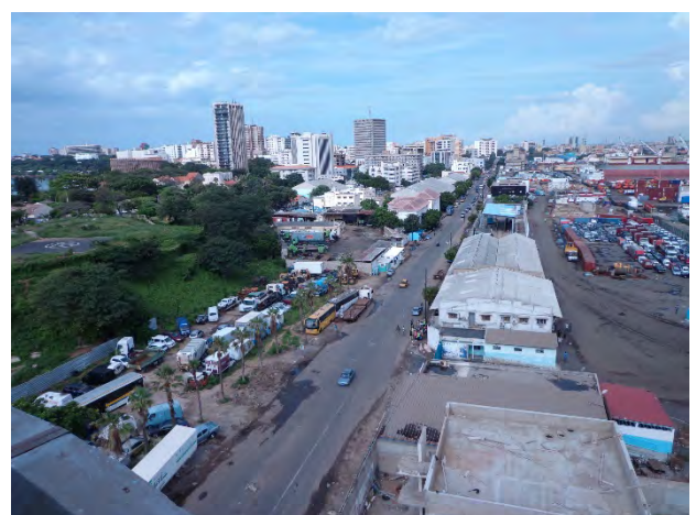
写真-20 現在閉鎖中の第3ゲート(中央 部)とそれに接続する道路(左側)
