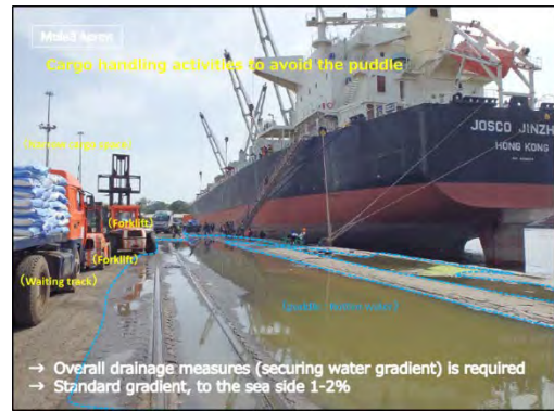
(5) 水溜りのために荷役作業ができない場所
