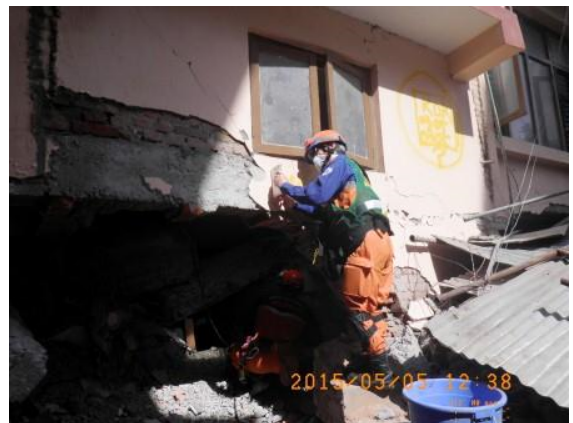
傾斜角度を測る構造評価隊員（ゴンガブ）
