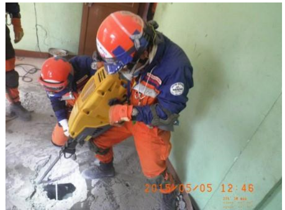
削岩機でサーチングホールを作成 （ゴンガブ）
