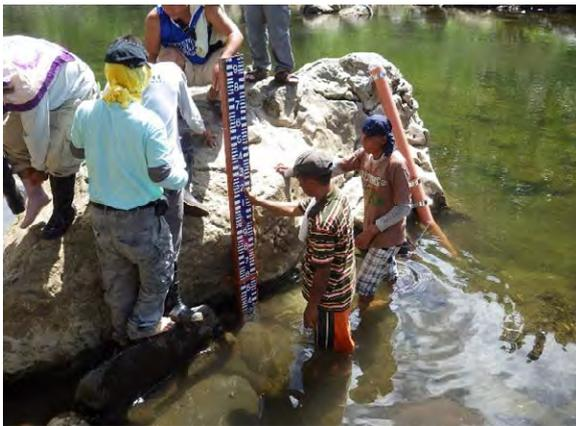
図 4-8 設置作業状況 (水位標)
