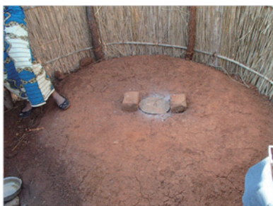
(Majune郡) 住民が新設したピットラトリン
