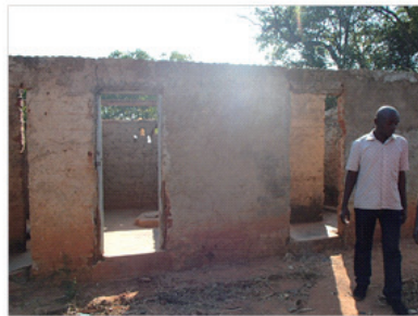
(Majune郡) 学校の既存トイレ 外景
