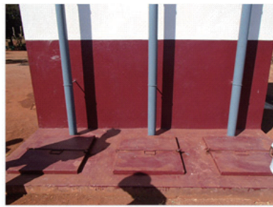
(Muenbe郡) 学校用トイレ かき出し口
