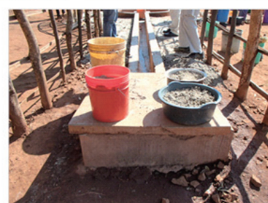
(Muenbe郡) 給水施設の浸透枴
