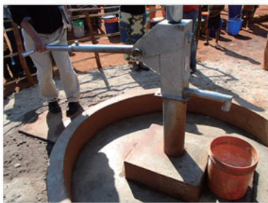
(Muenbe郡) 新設した給水施設
