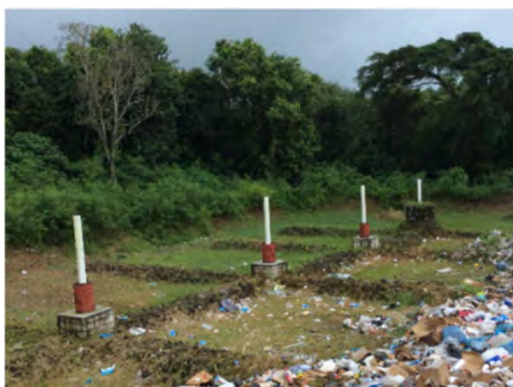
ヤップ州で新設された福岡方式最終処分場。本プロジェクトでは設計や運営を指導。
