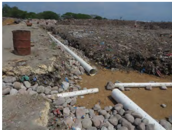
ホニアラ。ラナディ最終処分場の改善工事。
