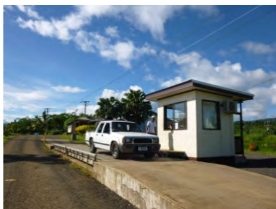
アピア（ウボル島）。タファイガタ最終処分場に導入されたウェイブリッジで計量中のごみ搬入車両。
