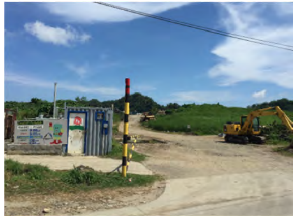
最終処分場外観。本プロジェクトにて一部改善工事及び運営や閉鎖計画の指導を実施。
