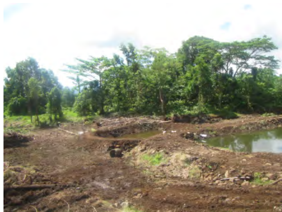
サヴァイ島。ヴァイアタ最終処分場に整備された浸出水処理施設（石・珊瑚・砂・ココナッツの殻の簡易浄化設備、沈殿池、浸出水池）。
