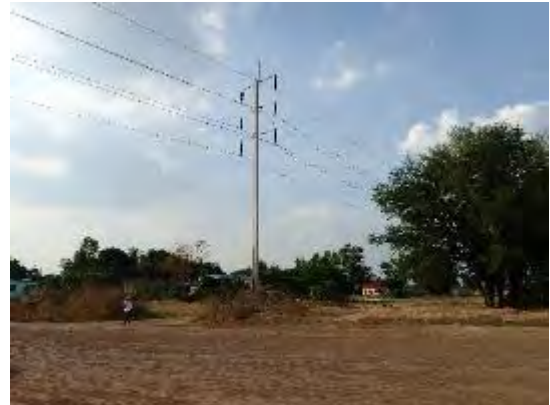
115kV 送電線との交差
