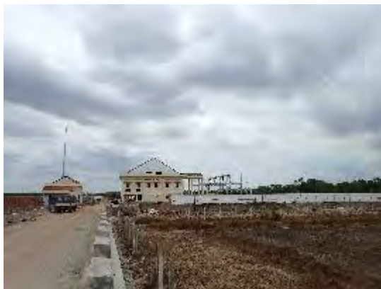
建設中の Chrak Mtes 変電所
