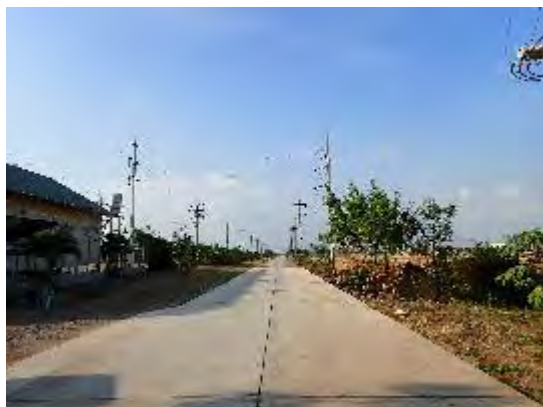
バンテアイミエンチェイ変電所
