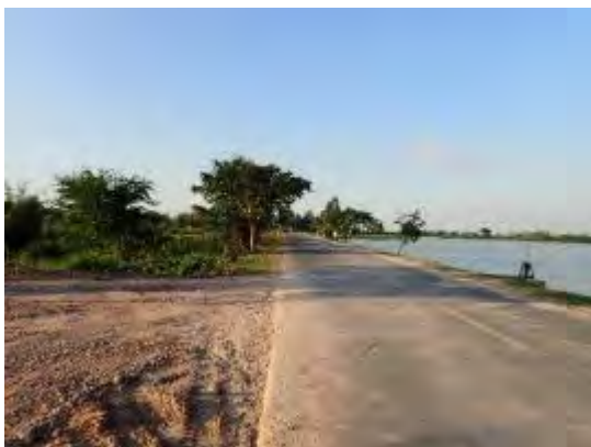
河川沿いの配電線ルート
