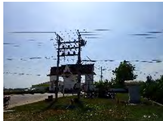
ルート端部(マンハッタン SEZ ゲート前)
