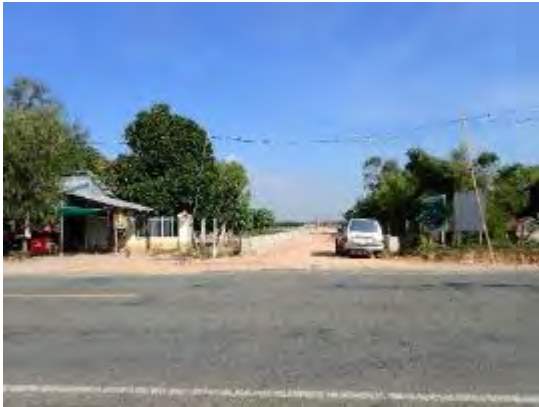
国道 1 号線沿いにある Chrak Mtes 変電所のゲート
