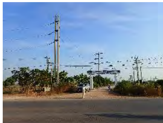
国道 5 号線沿いにある変電所ゲート
