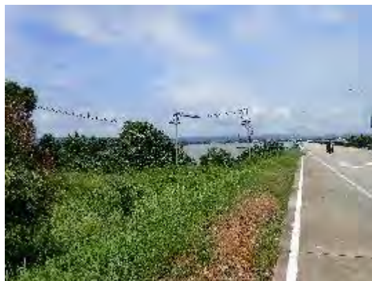
コッコン橋の端部付近
