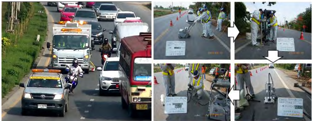
写真-3.6 写真左・探査車「スケルカ」計測状況(一次調査)と写真右・二次調査状況
