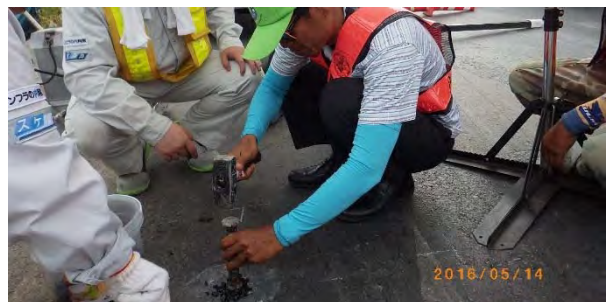
[削孔箇所埋戻し(現地職員への指導、試行)]
