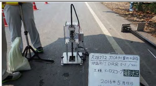
[空洞柱状写真撮影状況(運河道路)]
