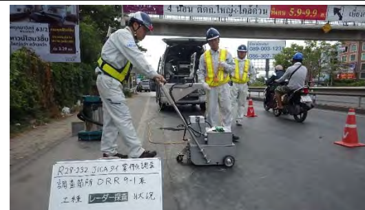
[空洞信号箇所での詳細調査状況(郊外道路)]
