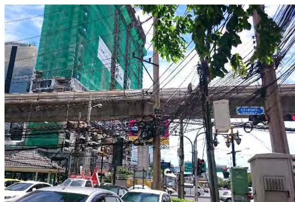
写真-3.10 バンコク都内道路の架線電線類
