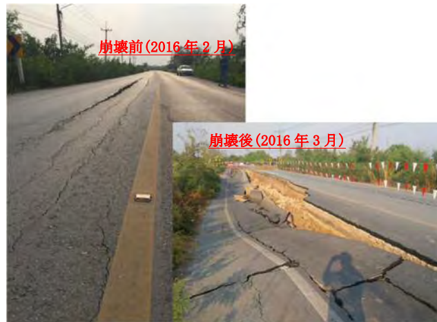
図-3.10 運河道路位置図と現地道路崩壊箇所(DRR4) [崩壊前(2016年2月)と崩壊後(2016年3月)]
