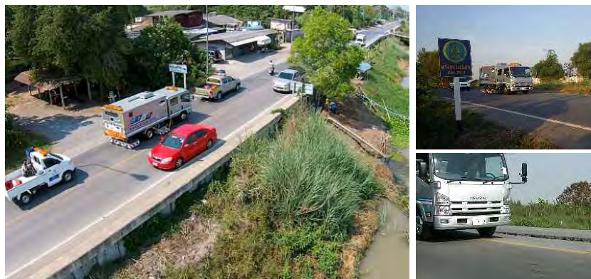
写真-3.2 計測状況 [運河道路]
