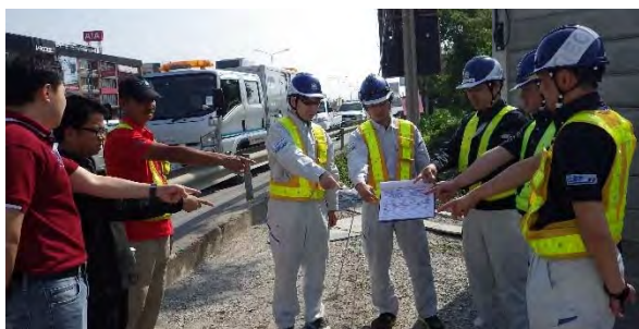
[現場計測前の安全確認ミーティング(毎日)]
