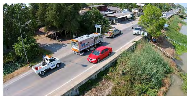
[スケルカー計測状況(運河道路)]
