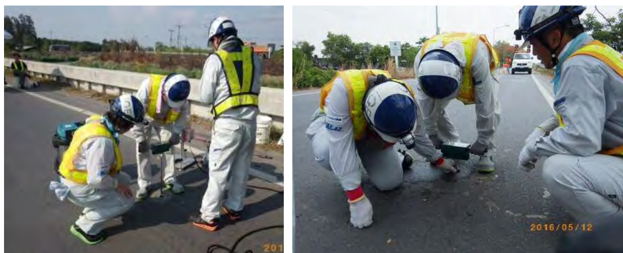
写真-3.8 ポータブルコーン貫入試験機によるゆるみ計測状況
