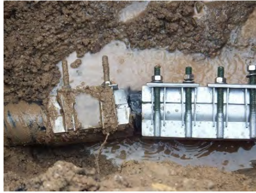
配水管漏水修理 (PE管クラックの修理状況)
