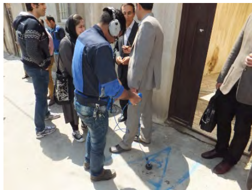
漏水位置探知
