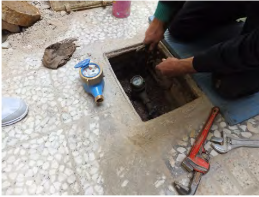
故障メータの交換作業
