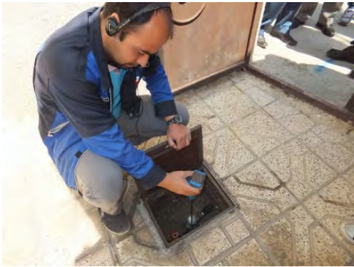
給水管の漏水探知
