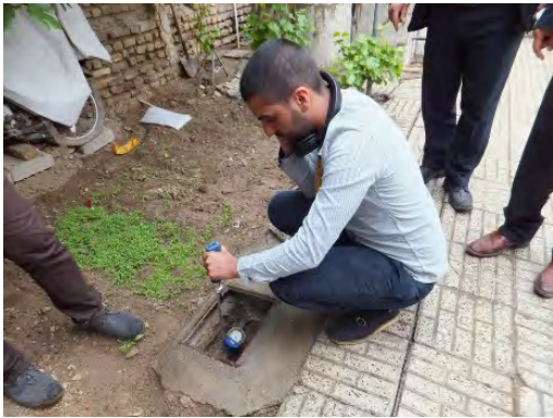
給水管での漏水探知
