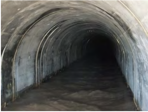
Qomrud トンネル
