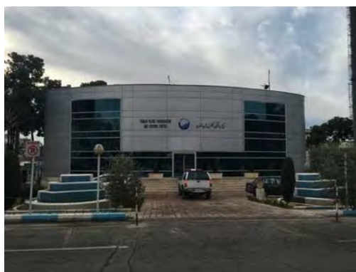
TPWWC コントロールセンター
