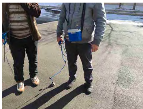
漏水調査現場
