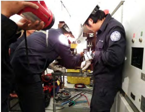
C/P による変電所設備の点検活動
