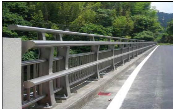
Figura 5-2-31 Vallas de seguridad de aluminio con consideración a la apariencia
