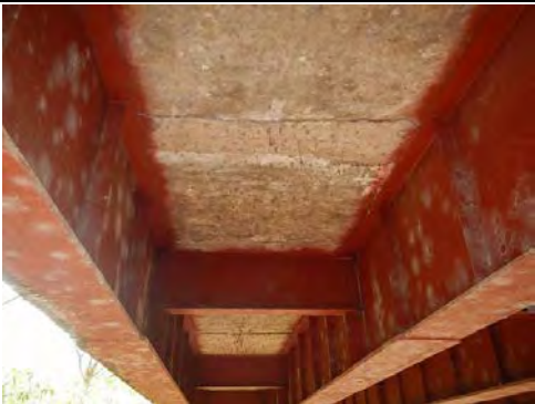
Fotografía-11 Cara inferior de la losa
