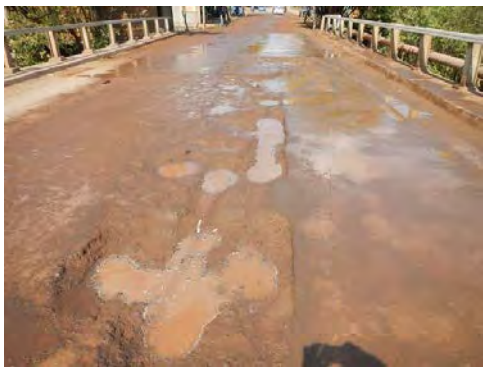
Fotografía-3 Daños en la pavimentación
