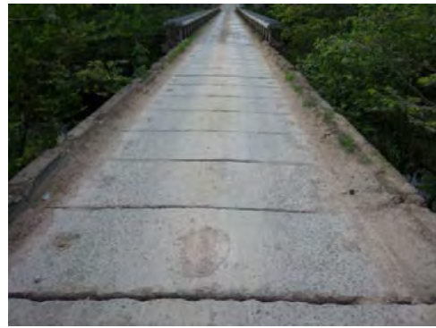
Fotografía-20 Losa sobre la viga I en el claro extremo
