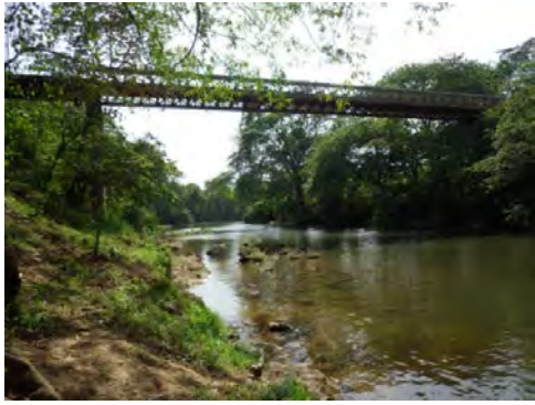
Fotografía-17 Vista panorámica del puente existente
