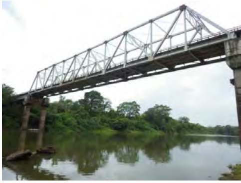
Fotografía-1 Vista panorámica del puente existente
