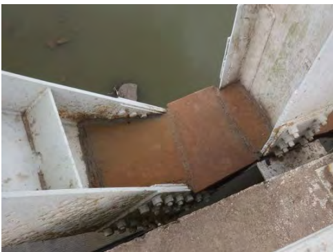
Fotografía-5 Reforzamiento de placa en nodo (Reforzamiento con lámina de acero)
