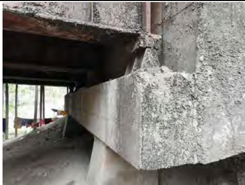
Fotografía-12 Soporte del estribo y borde de la viga
