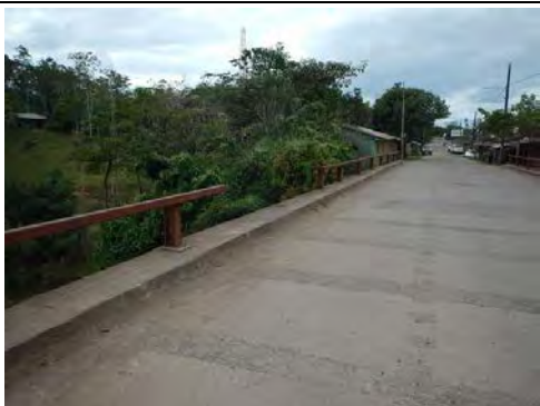
Fotografía-13 Daños en la baranda
