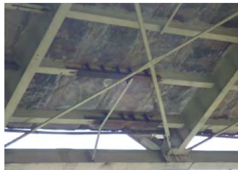
Fotografía-6 Reforzamiento de la viga longitudinal de la armadura
