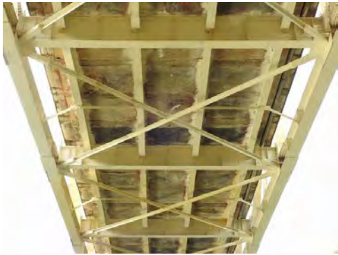
Fotografía-27 Cara inferior de la losa
