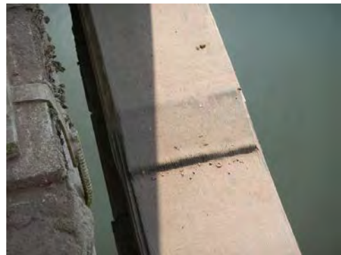
Fotografía-4 Reforzamiento de la armadura (Reforzamiento con fibra de carbono)
