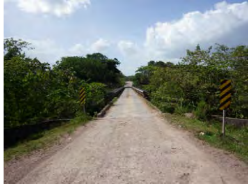
Fotografía-18 Superficie del puente existente
