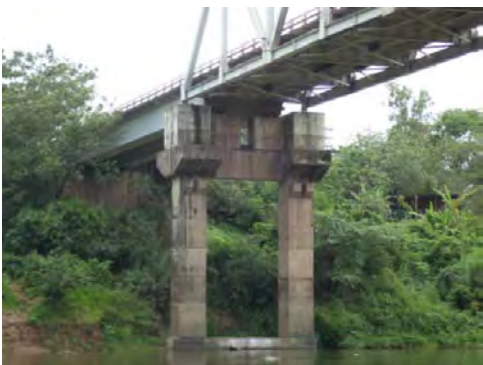
Fotografía-7 Pila dentro del río
