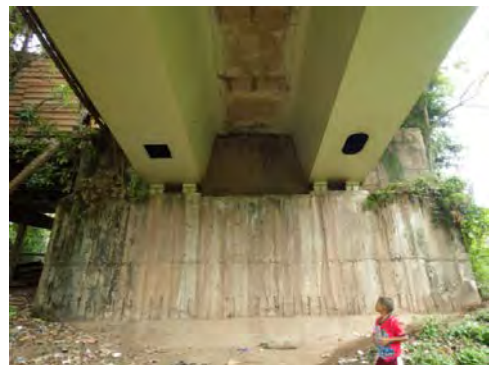
Fotografía-8 Estribo y viga de cajón de acero del claro extremo
