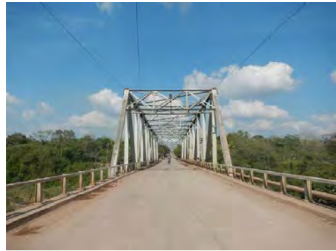
Fotografía-2 Superficie del puente existente
