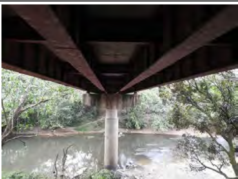
Fotografía-14 Pila dentro del río
