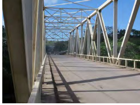
Fotografía-26 Superficie del puente existente
