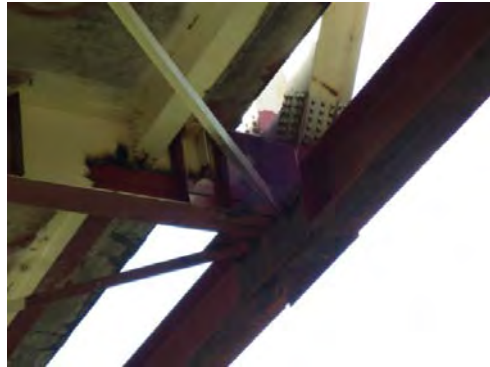
Fotografía-32 Reforzamiento de la placa en nodo (Fotografía tomada en octubre de 2015)
