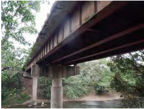
Fotografía-9 Vista panorámica del puente existente
