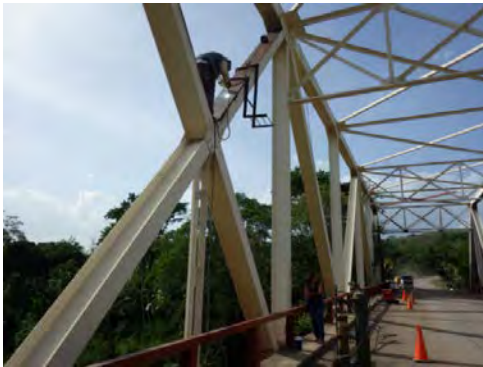
Fotografía-31 Reforzamiento de la diagonal de la armadura (Fotografía tomada en octubre de 2015)
