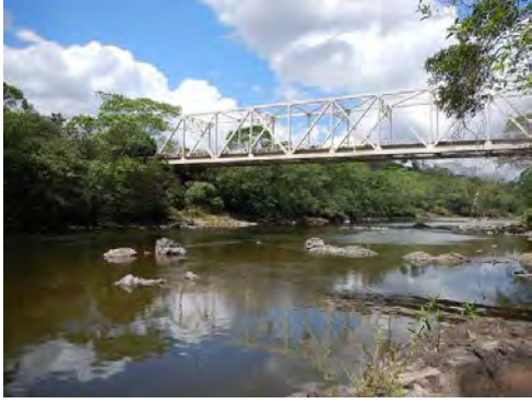
Fotografía-25 Vista panorámica del puente existente
