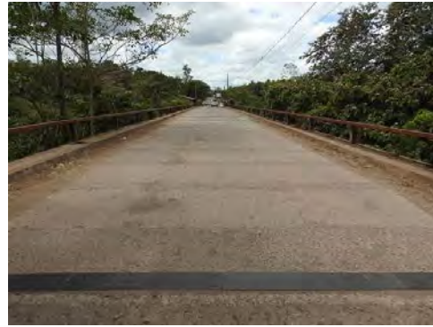
Fotografía-10 Superficie del puente existente
